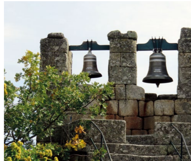
Pormenor dos sinos no campanário, Sortelha, Portugal. Bells in the steeple (detail), Sortelha, Portugal.
