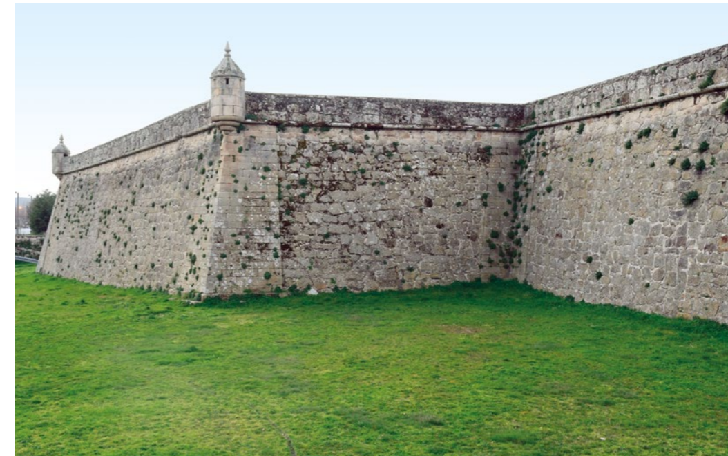
↑ Muralha do baluarte, Forte de São Neutel. Bastion Wall, São Neutel Fort.
